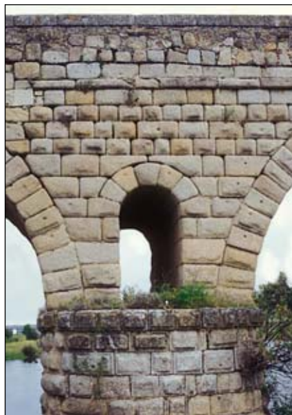
Aparejo de opus quadratum en el puente romano de Mérida.
