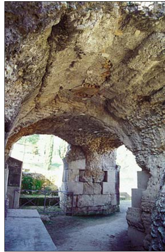
Bóvedas de arista del anfiteatro de Itálica.
