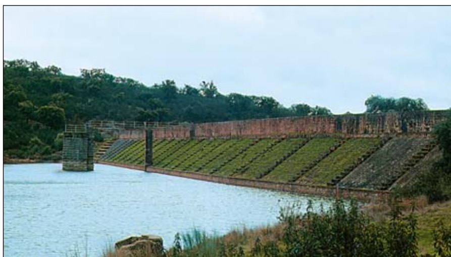
Talud de aguas arriba de la presa de Cornalvo.
