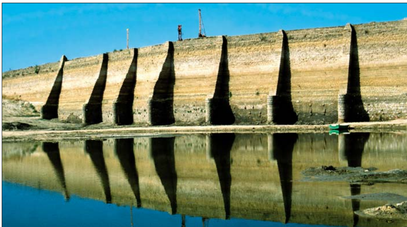
La presa de Proserpina (Badajoz), construida en granito para abastecer de agua a Mérida. Foto Caballero.
