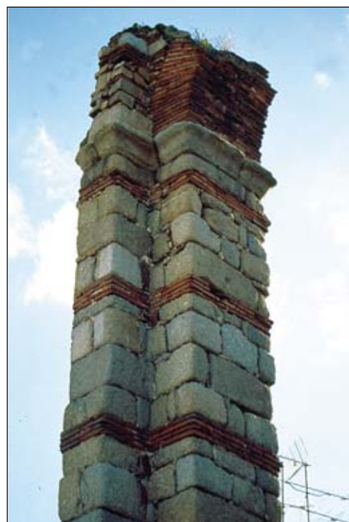
Opus mixtum , con hiladas de piedra y ladrillo, en el acueducto de San Lázaro (Mérida).
