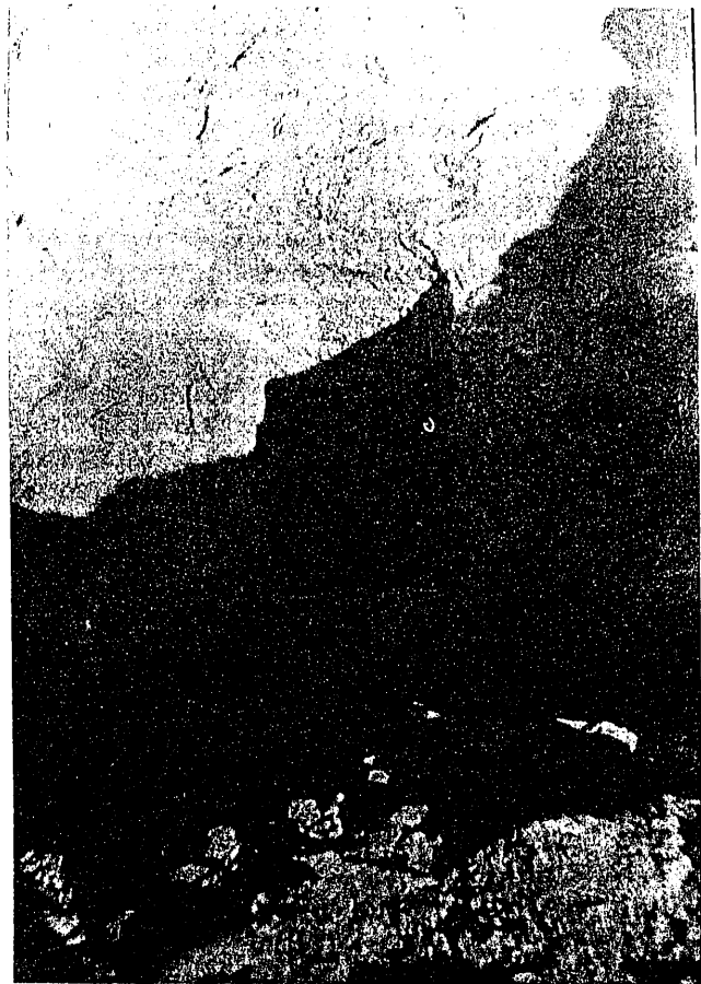
Cimiento de la pila nº 7. Vista desde la superficie del terreno destacándose el fondo del cimiento en yeso masivo. En el centro se sitúa la perforación en pozo romano.
